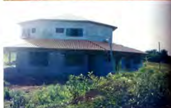
O início da construção da sede social de Dourados.
