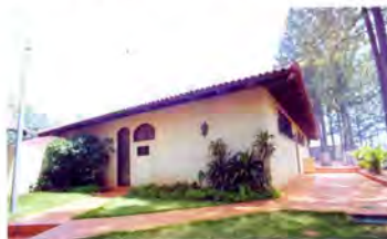
Prédio da sauna na Sede Campestre de Campo Grande.
