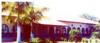
Ampliação do salão social: área construída 511 m 2 .
